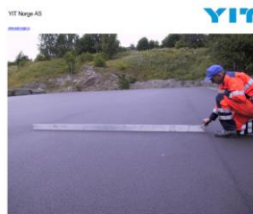
Ska 11. Pmb Asfalt (slitelag)
